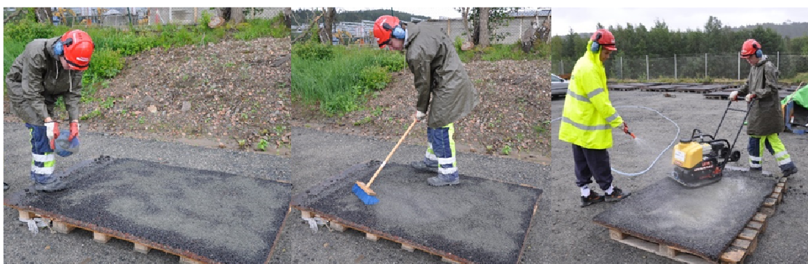
Figur 5.13 Nedsmutsning av provplattor med "riktigt" vägsmutset.
