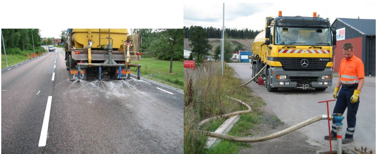
Figur 4.11. Förvattning av ytan samt påfyllning av vatten.
