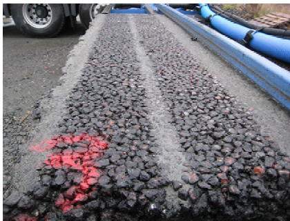
5. Visuell kontroll av resultatet direkt efter körning.
