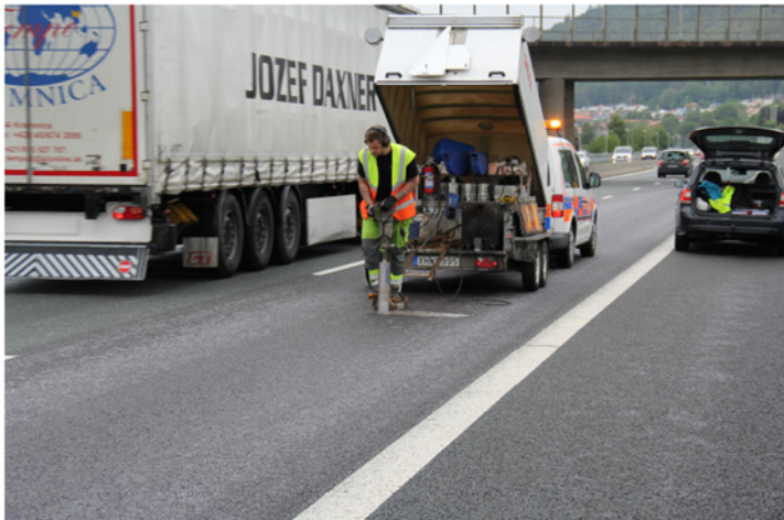
Figur 5.42 Borring av provkroppar från E4 Huskvarna.
