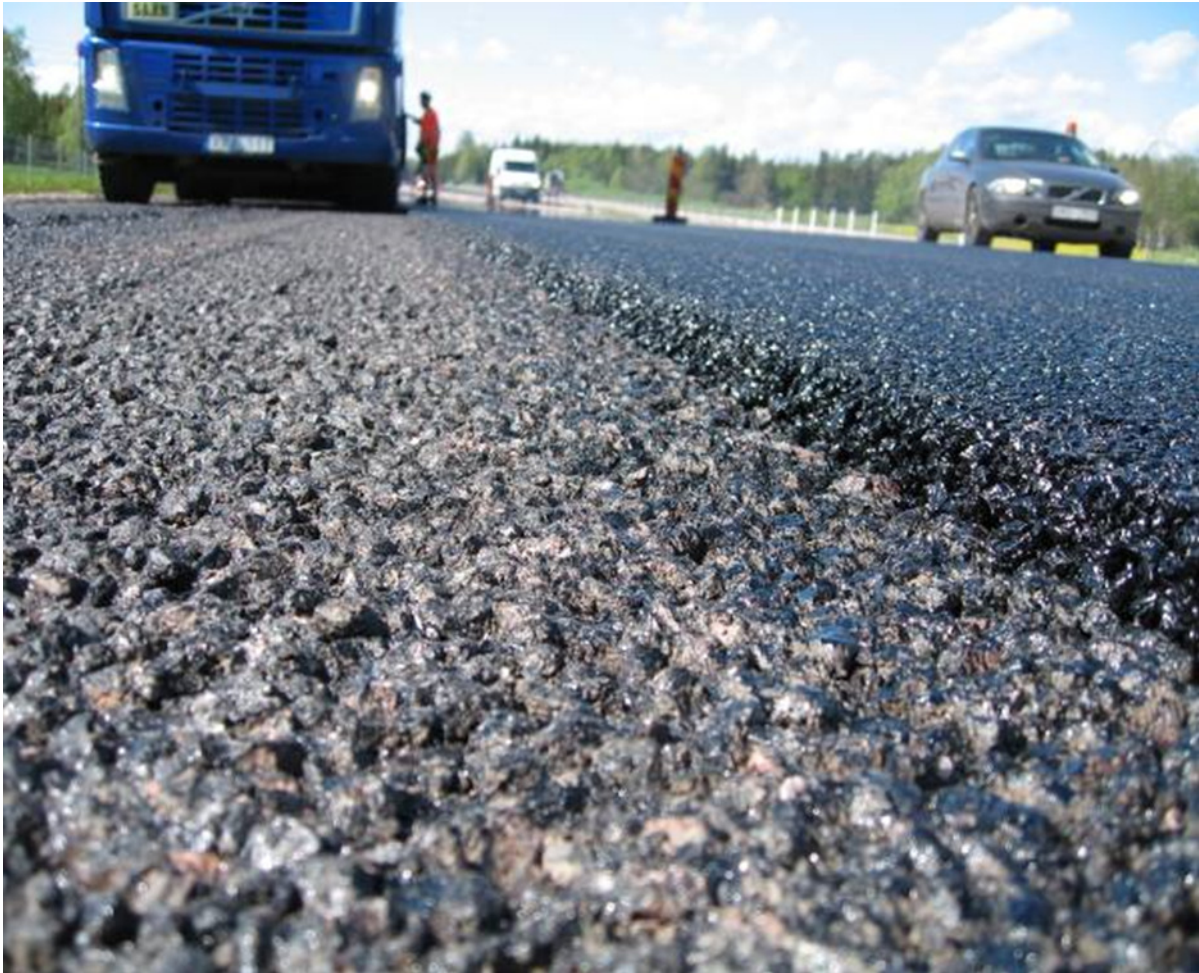
Figur 5.58 Rengöring av underliggande lager vid omtoppning av övre lager.
