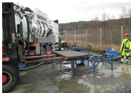
2. Provpatta lyfts på plats i riggen med truck. Sugbil kopplas in.
