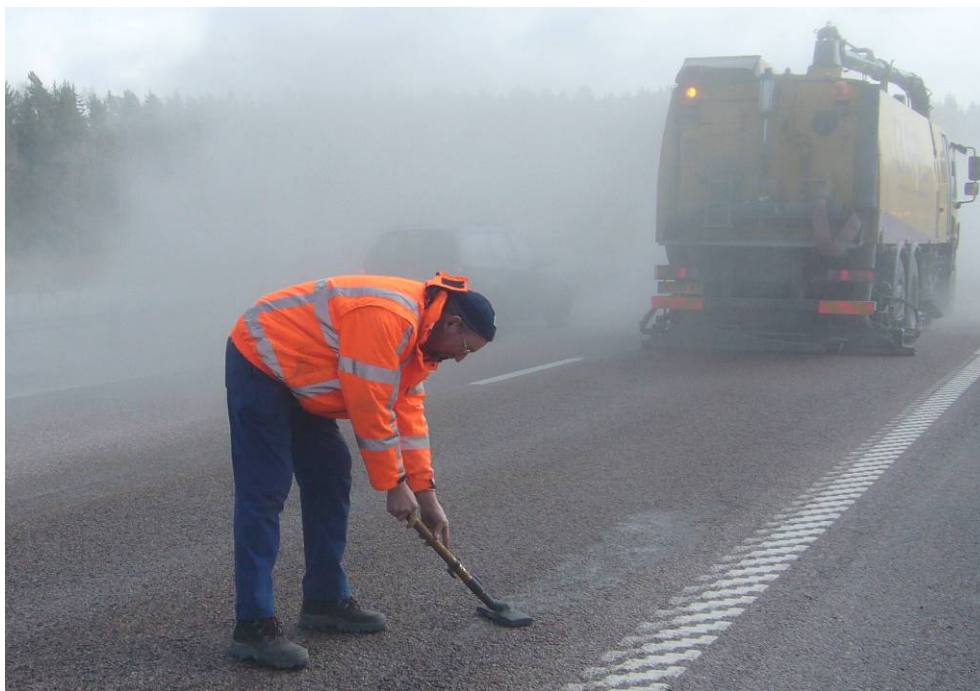
Figur 4.1. Högteknologisk rengöringsutrustning samt lite enklare utrustning för rengöring av öppna beläggningar.
