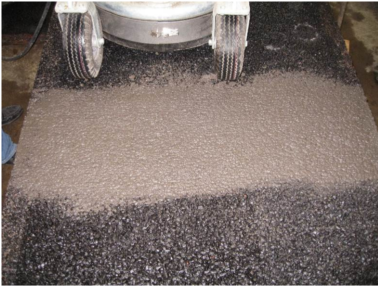
Figur 5.9 Färdigpreparerad provplatta före rengöringsförsök.
