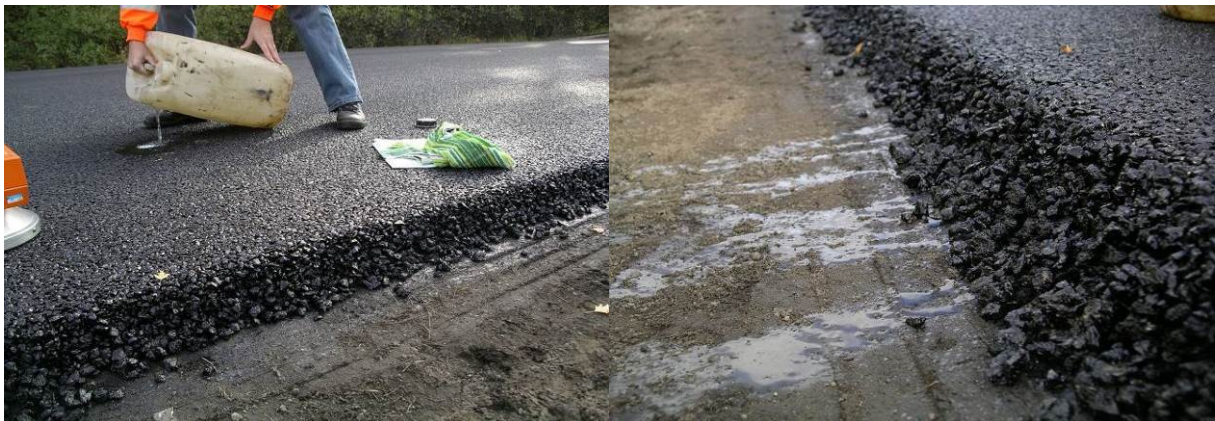
Figur 2.1 Öppen porstruktur med god dränerande egenskaper.
