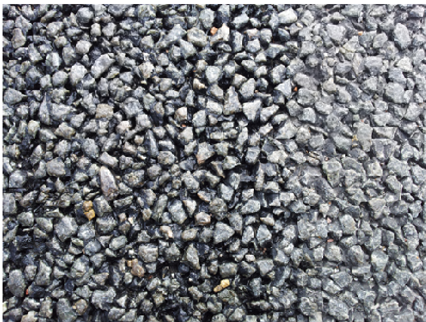
Figur 5.52 Visuell effekt av rengöring med VÄGREN.
